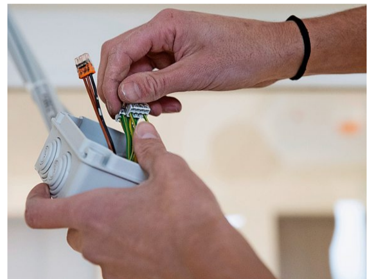
Mit den Händen arbeiten, das entspricht dem angehenden Elektroinstallateur sehr.
