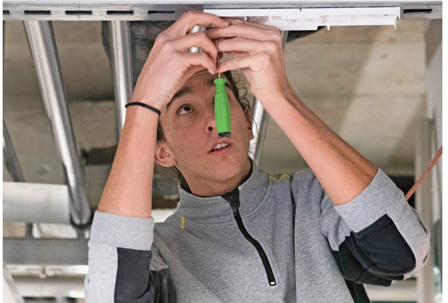
Nicola Liechi beim Montieren einer Lampe auf der Baustelle Aarhus in Gümligen. Fotos: Christian Pfander
